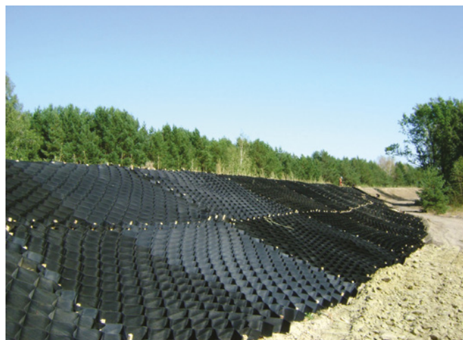
Укрепление откосов георешеткой. © consalststroy-geo.ru
