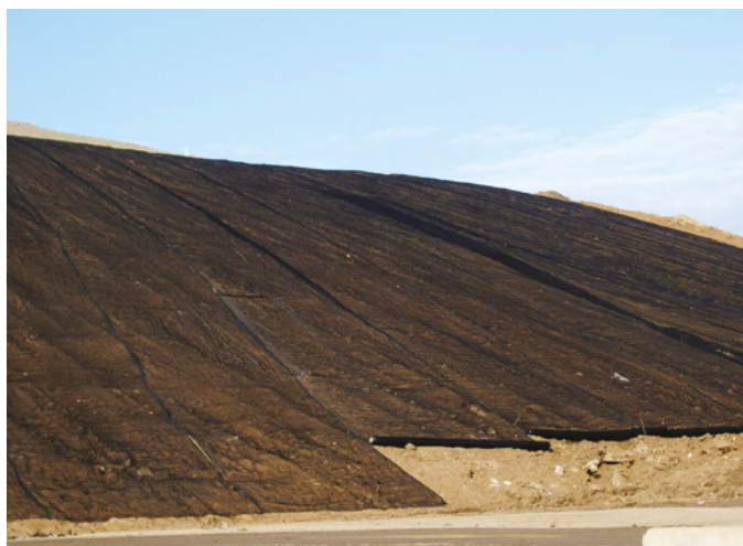
Укрепление откосов геоматами. © azov-gabion.ru
