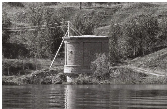
Водозаборное сооружение поверхностных источников. ©n7Lru
