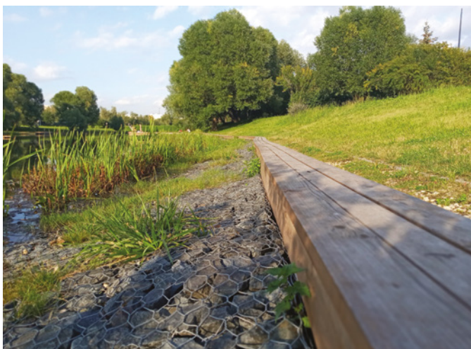
Укрепление откосов габионной конструкцией. © Fantalis
