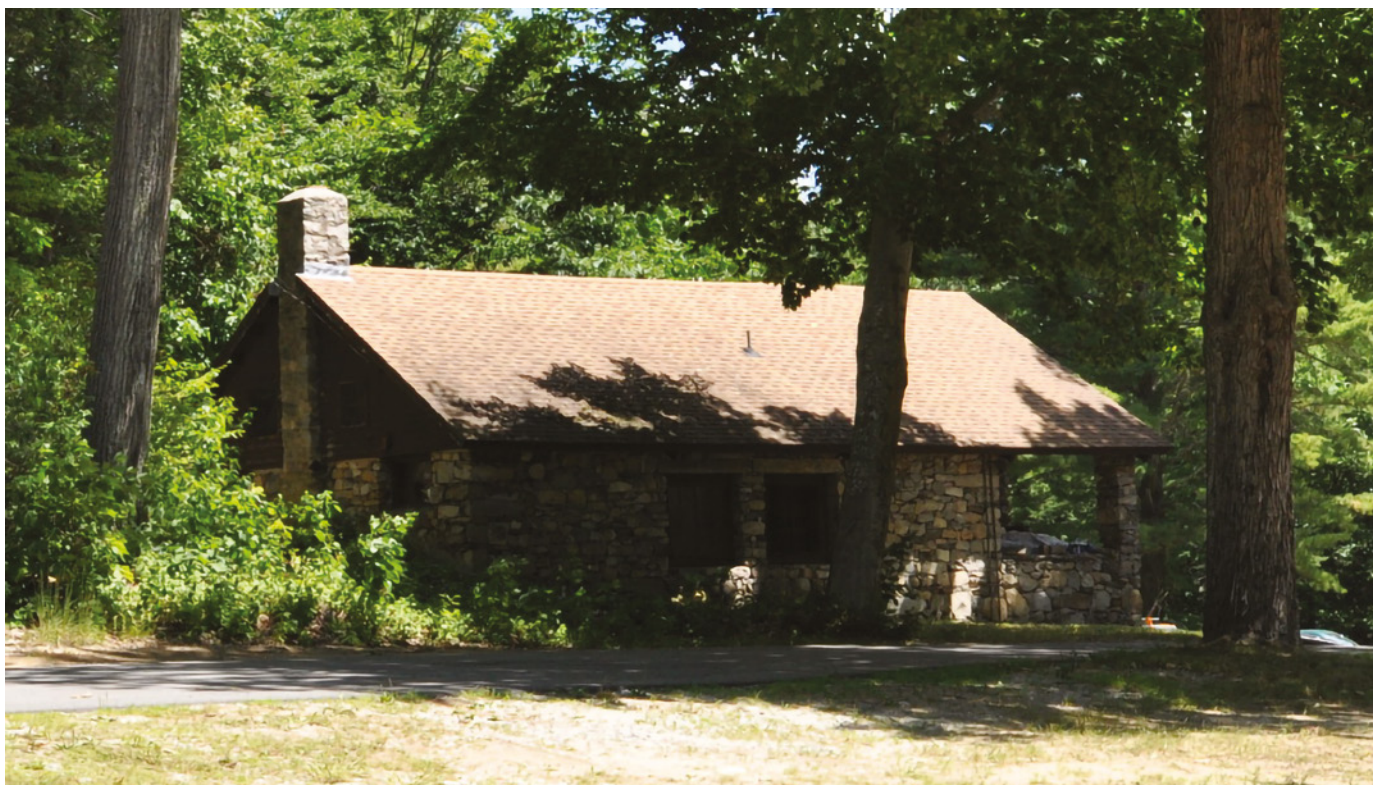
Здание администрации в государственном парке «Бурр-Понд», Коннектикут, США. (Paugnut Forest Administration Building, in Burr Pond State Park, Connecticut, USA)
